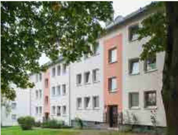
Kassel, Ziegenhainerstr., ICD 5 Maßnahmen: Sanierung Außenfassade mit Installation eines Wärmedämmverbundsystems gemäß aktueller EnEV
