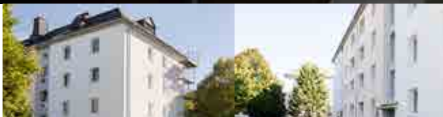
Abbildungen: Wetzlar, Magdalenenhäuser Weg
